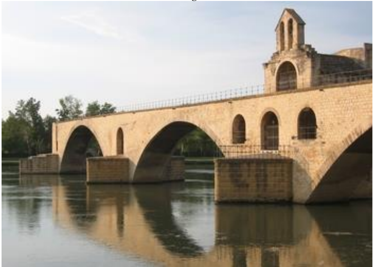
Trecho da ponte ainda existente, com a capela de Saint-Bénézet. Postal antigo – coleção do autor.
